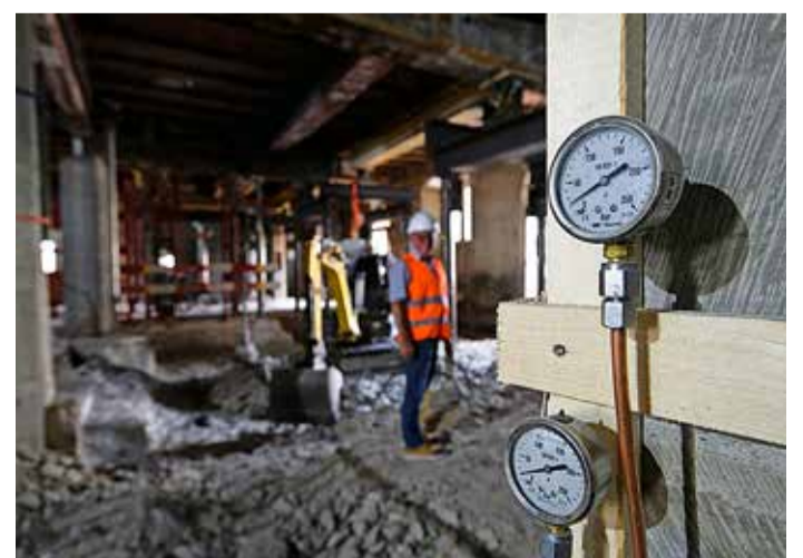
Die Statik des Rathauses wird permanent überwacht.
