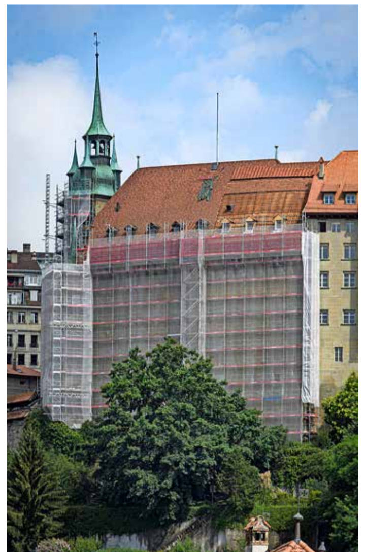
Auch die Fassaden erfahren eine Auffrischung.
